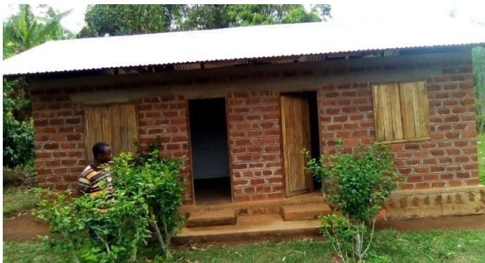
Vue extérieure du bâtiment A
