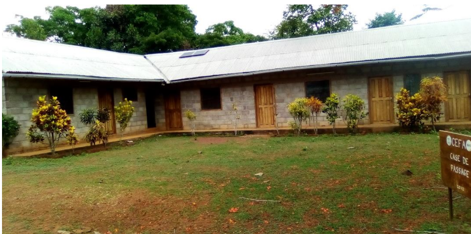
Vue extérieure de la case de passage
